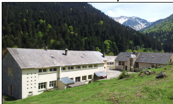
CENTRE D'ARTIGUES Pyrénées
